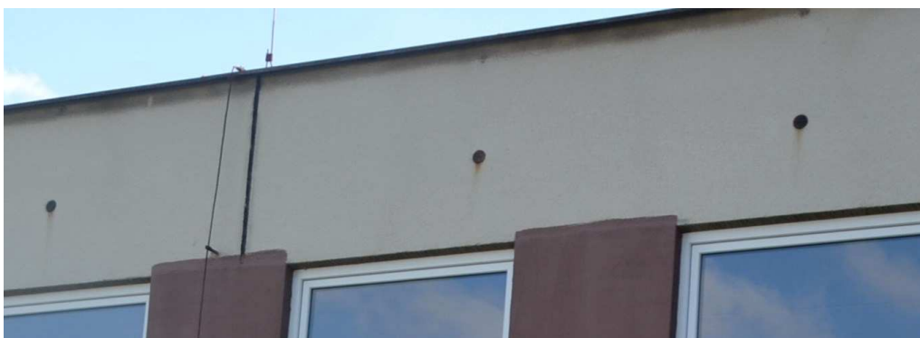
Obr 4: Většina větracích otvorů je uzavřena mřížkami.
