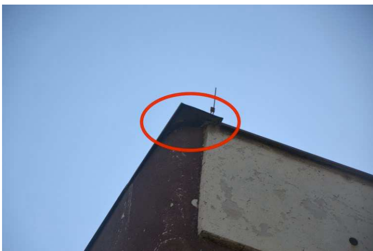
Obr 6: Štěrbina mezi oplechováním a panelem na severovýchodním rohu budovy.
