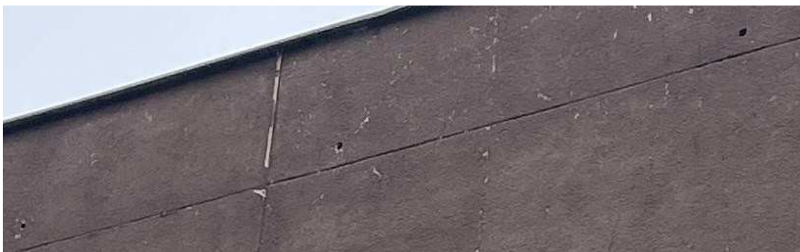
Obr 5: Větrací otvory na štítech jsou volné, ale velmi malého průměru.
